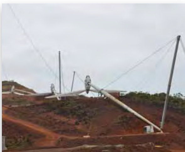
Parc éolien du Mont-Dore d'une puissance de 4 950 kw (18 aérogénérateurs Vergnet de 275 kw). Partenaire : AéroWatt. Société projet : AéroWatt Énergies.
